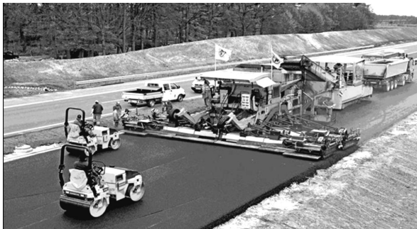
Рисунок 7 – Укладка асфальтобетонной смеси на всю ширину проезжей части
